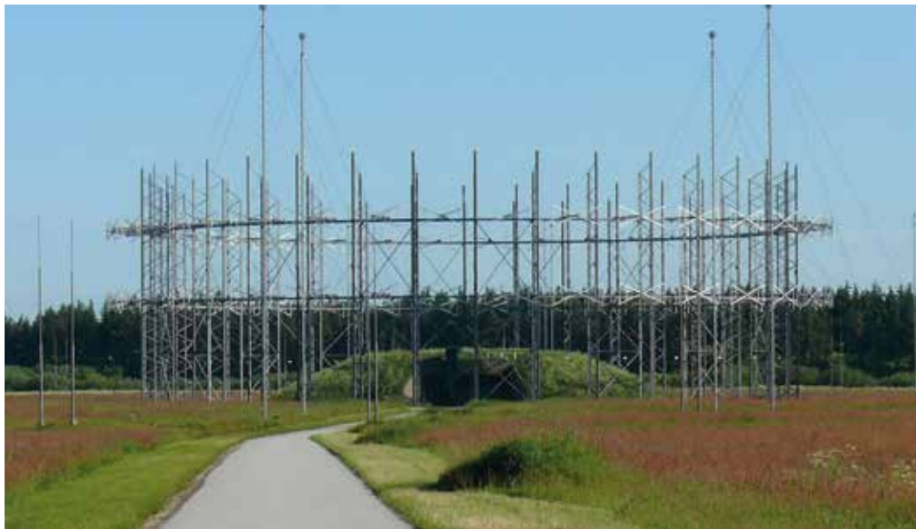
Ein Antennenfeld zur Signalerfassenden Aufklärung der Fernmeldeaufklärungszentrale Nord, die dem Kommando Aufklärung und Wirkung unterstellt ist
